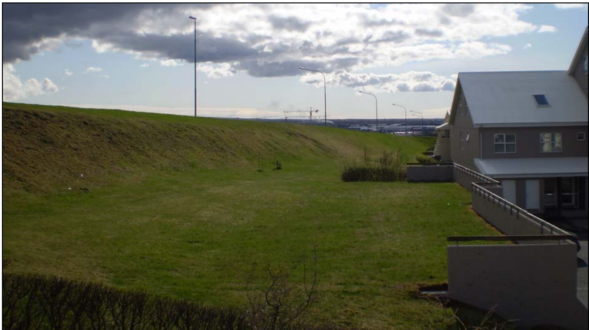
Mynd 5.11 Mynd tekin við Fagrahvamm 4 og sýnir núverandi hljóðmön, um 2 m háa yfir vegi, meðfram Reykjanesbraut (ljósmynd: Mannvit 2007).
