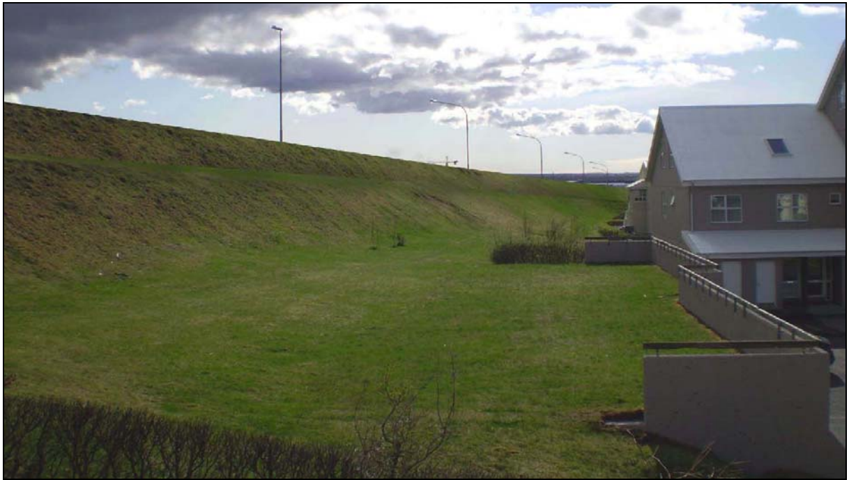
Mynd 5.12 Mynd tekin við Fagrahvamm 4 og sýnir kost 2 , það er 4 m háa gabíon hljóðmön og Reykjanesbraut með óbreytta hæðarlegu (ljósmynd: Mannvit 2007).
