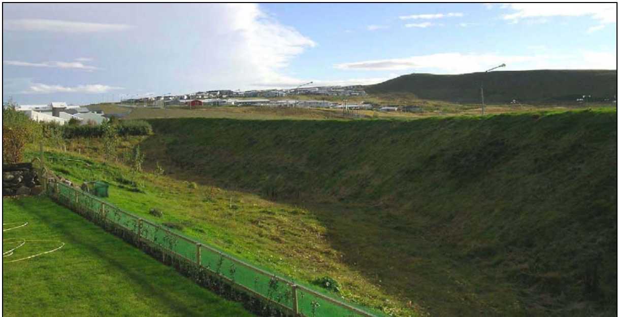
Mynd 5.29 Mynd tekin við Vallarbarð 19-21 og sýnir kost 1 , það er núverandi hljóðmön og gabíon hljóðmanir meðfram lækkaðri Reykjanesbraut fjær (ljósmynd: Mannvit 2006).
