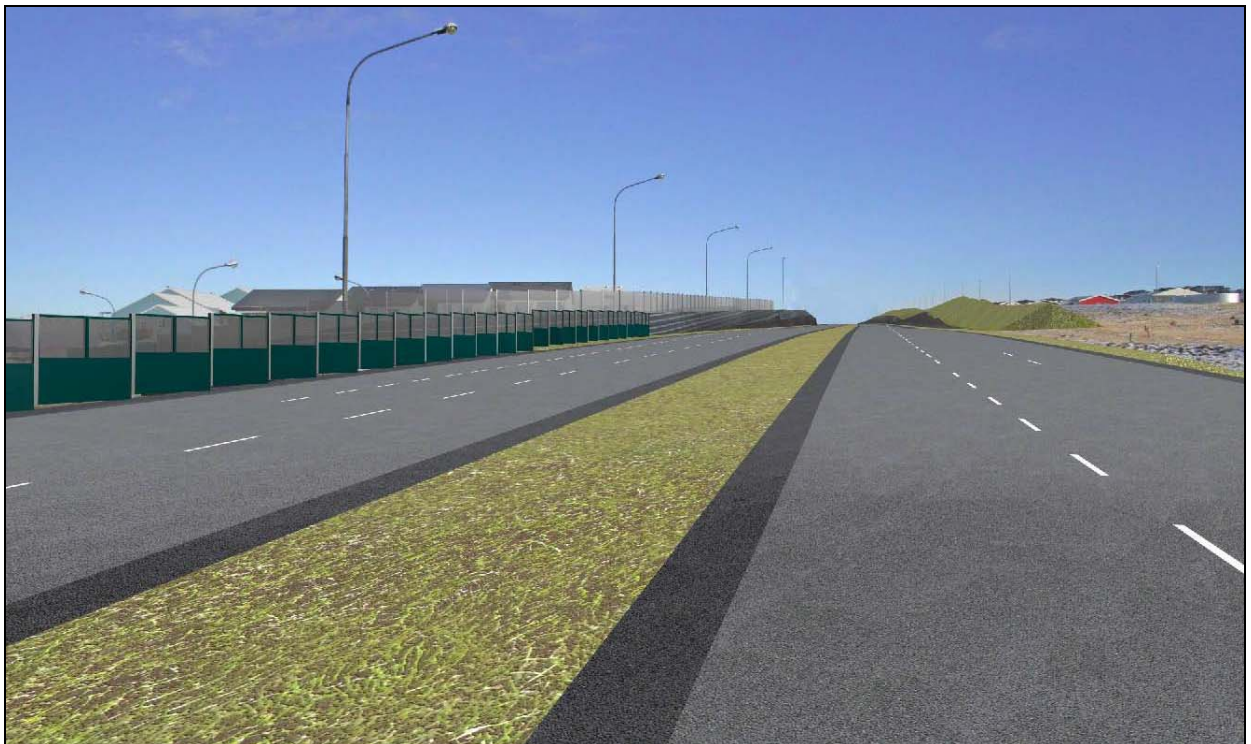
Mynd 2.10. Mynd tekin austur að vegamótum við Strandgötu. Fyrirhuguð breyting á Reykjanesbraut, kostur 1 , sett inn á myndina. Á þessum stað verður hæðarlega Reykjanesbrautar óbreytt, bundin við brú á vegamótunum.
